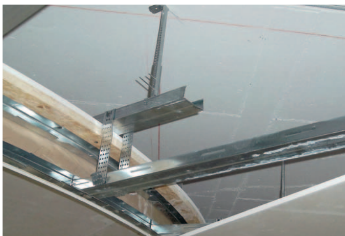
Детали: потолочный выступ (Фото: Ruben Peter Ausbau GmbH)
