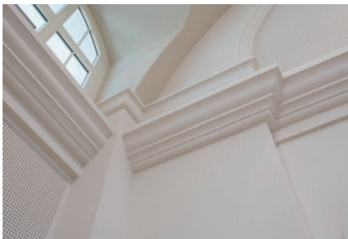
Карнизы с завода: ранее заготовленные элементы конструкции в комбинации с гипсовыми декоративными элементами
