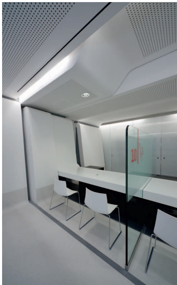
Обшивка потолка акустическими плитами КНАУФ-Акустика (Фото: Knauf / Albert)
