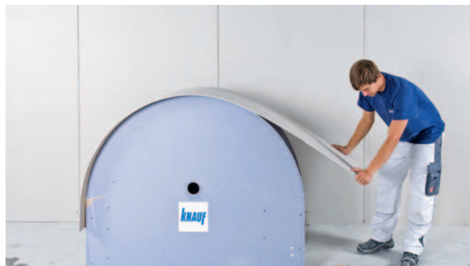
Рис. 4: Фиксация гипсокартонных КНАУФ-листов на шаблоне
