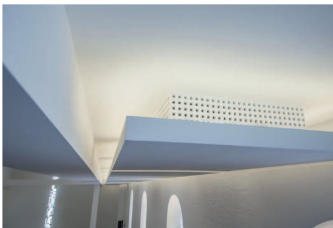
Потолочные сегменты из акустических плит Knauf Tectopanel под штукатурку поглощают звук внутри церкви.
