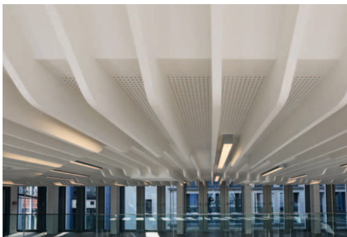
Совершенная интеграция потолочного короба в интерьер посредством установленных на ребро и уходящих вверх ламелей
