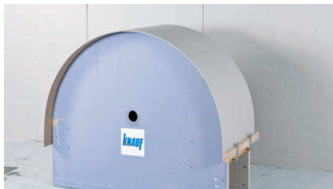
Рис. 4: Фиксация гипсокартонных КНАУФ-листов на шаблоне
