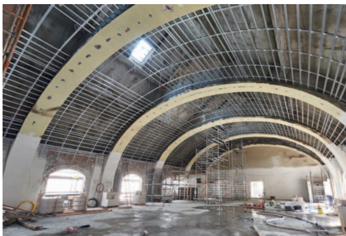
Подконструкция потолка, к которой крепились перфорированные гипсокартонные плиты KNAUF-Акустика, расположена между несущими рамами
