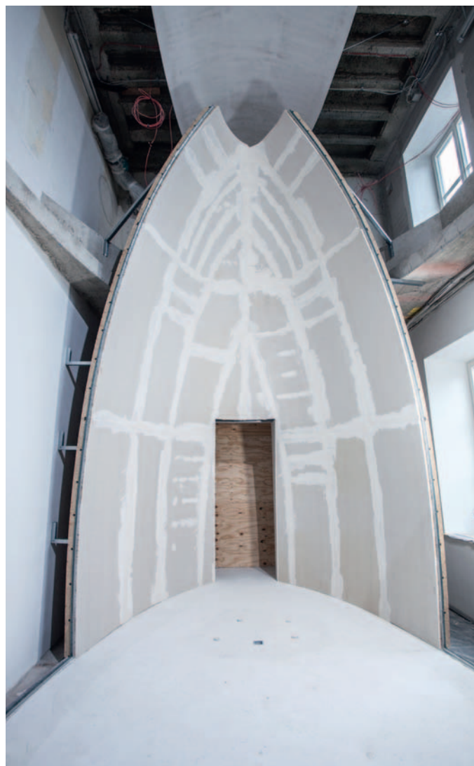
Ранее заготовленные элементы образуют систему «пространство в пространстве».
