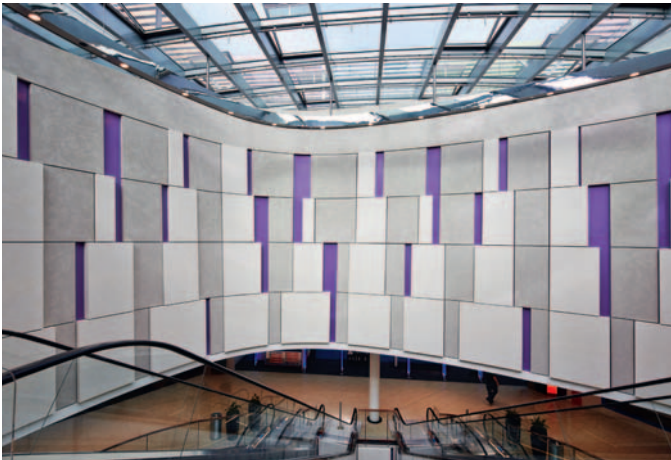
Цветные, изогнутые с разными радиусами элементы рельефных структур на поверхностях стен молла сделаны из предварительно изготовленных гипсокартонных КНАУФ-листов.
