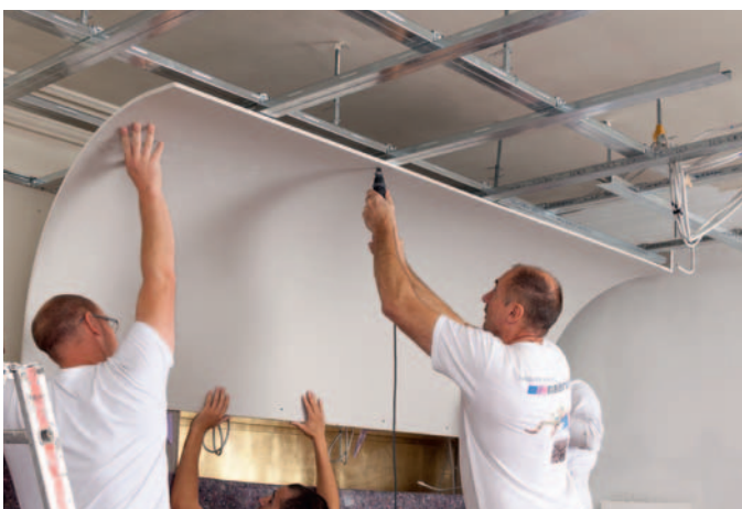
Специалисты по сухому строительству соорудили парящий потолок над нишами для сидения в зоне отдыха из предварительно изготовленных плит, чтобы сократить время монтажа до минимума.
