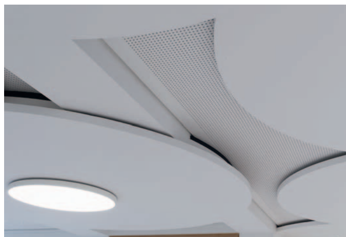
Новый потолок состоит из трех уровней и при этом декорирует низко расположенные железобетонные балки (Фото: Knauf/ Klemens Ortmeier)
