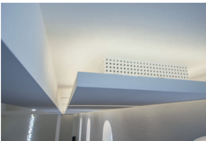
Потолочные сегменты из акустических плит Knauf Tectorpanel под штукатурку поглощают звук внутри церкви.
