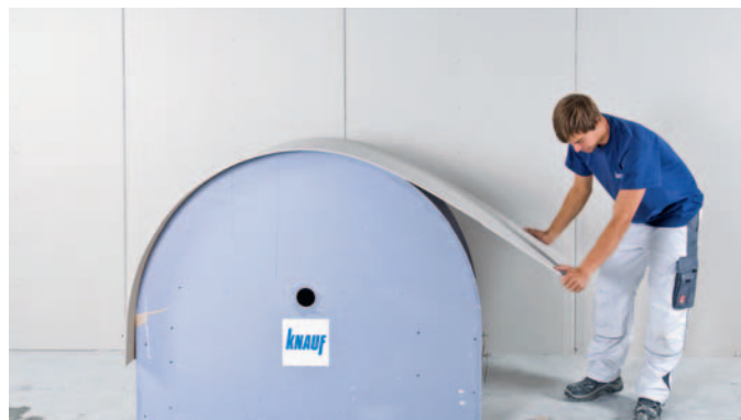
Рис. 4: Фиксация гипсокартонных КНАУФ-листов на шаблоне
