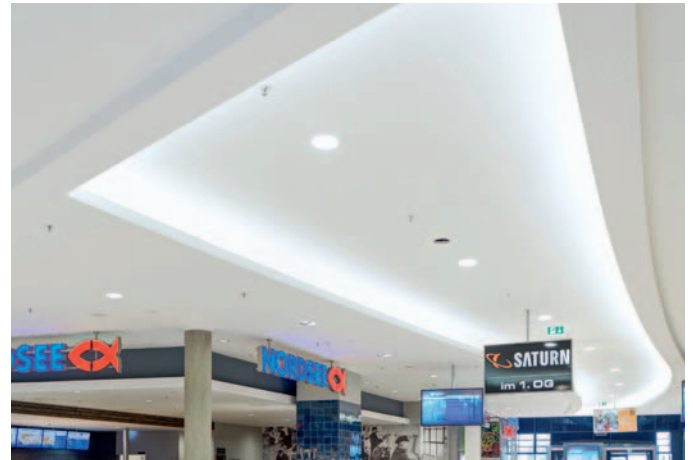
Заглубленные потолочные плоскости со светящимися вутами направляют посетителей и мастерски выделяют проходы между магазинами. Одних только Г-образных ранее заготовленных элементов было установлено 2500 погонных метров.
