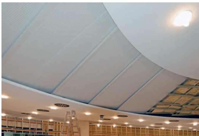
Фрагмент потолочной конструкции в конференц-зале окружного муниципалитета в Детмольде (Фото: Jaeger Ausbau)
