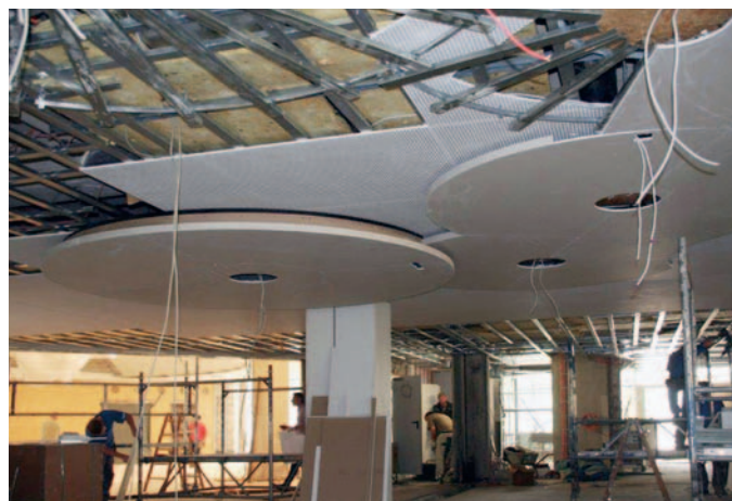
Трехуровневая потолочная конструкция фойе на этапе строительства (Фото: Jaeger Ausbau)
