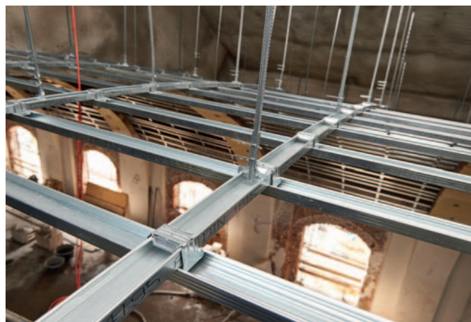
Изогнутые основные профили конструкции подвесного потолка были предварительно изготовлены на заводе с соблюдением требуемых радиусов и поставлены на строительную площадку
