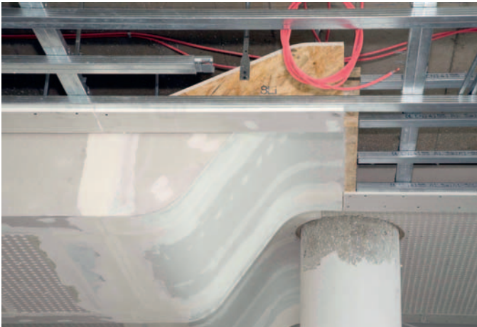
Потолочные выступы S-образной арочной формы
