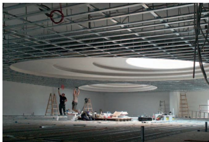
Детали: потолочная конструкция в Институте им. Макса Планка (Фото: Ruben Peter Ausbau GmbH)
