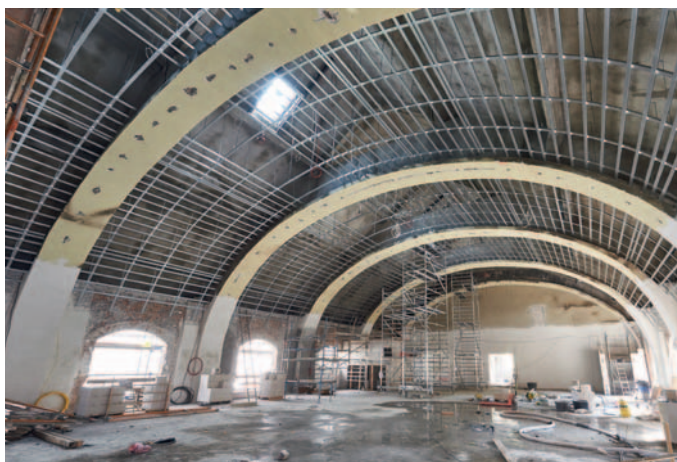
Подконструкция потолка, к которой крепились перфорированные гипсокартонные плиты КНАУФ-Акустика, расположена между несущими рамами
