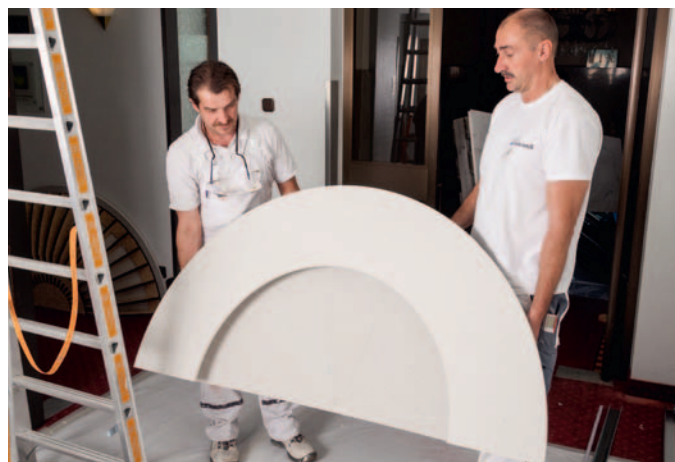
Отдельные детали купольной конструкции были поставлены по сегментам.
