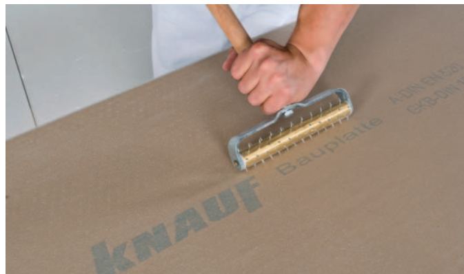
Рис. 2: Укладывание гипсокартонных КНАУФ-листов на шаблон
