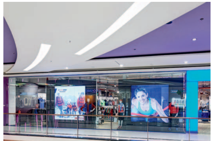
Парящие потолочные элементы свободной формы со встроенными в них изогнутыми светящимися вутами обеспечили правильное освещение коридоров и галерей. Потолочные сегменты состоят из 10–12 предварительно изготовленных отдельных элементов.
