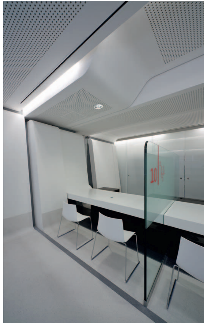
Обшивка потолка акустическими плитами КНАУФ-Акустика (Фото: Knauf / Albert)
