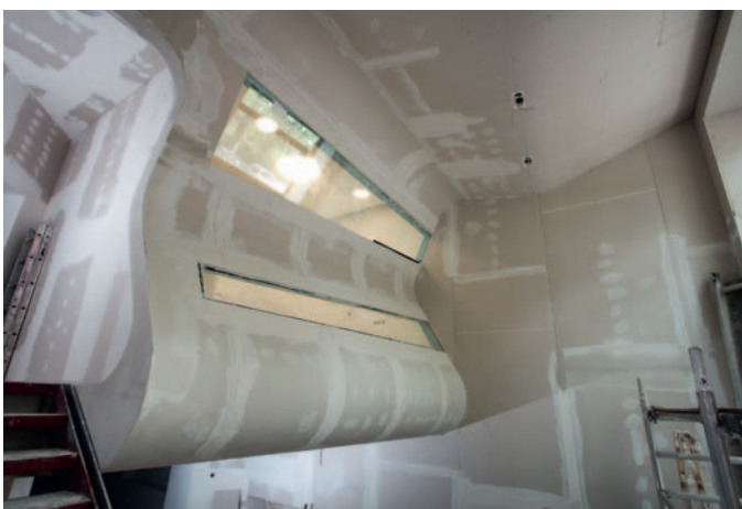
Работы по сухому строительству от нижнего к верхнему этажу (Фото: Gallandi)
