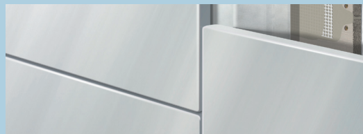
Облицовка композитным материалом
